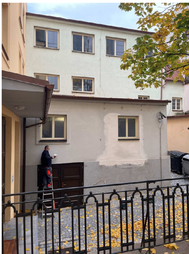
Výměna oken - budova skladu
