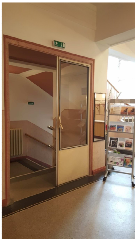
Výměna dveří do foyer
